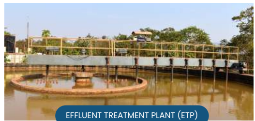
EFFLUENT TREATMENT PLANT (ETP)
